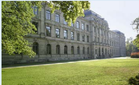
Universitätsgebäude in Erlangen
